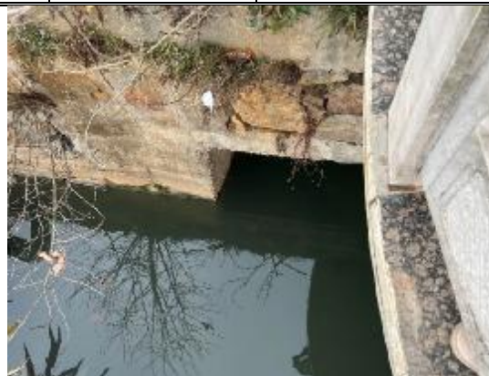
图 2-7 锦绣良缘排口现状照片
