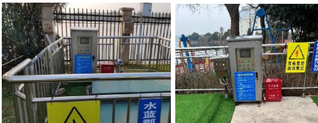
图 2-9 排口处一体化截污泵站
