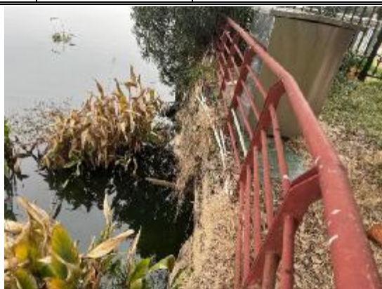
图 2-6 水蓝郡排口现状照片
